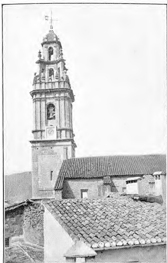
PEGO.—TORRE DE LA IGLESIA
