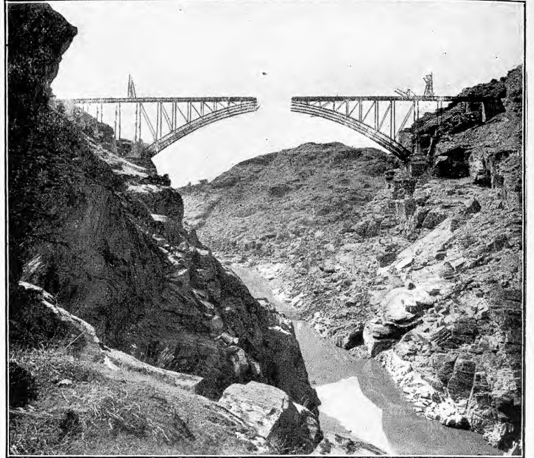
ALCAÑICES. — PUENTE EN CONSTRUCCIÓN SOBRE EL DUERO
