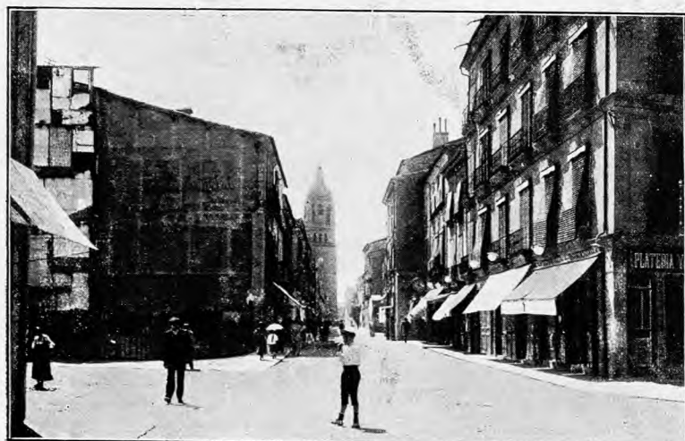
CALLE DE LA RUA
