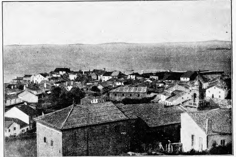
CARRIL. — VISTA PARCIAL
