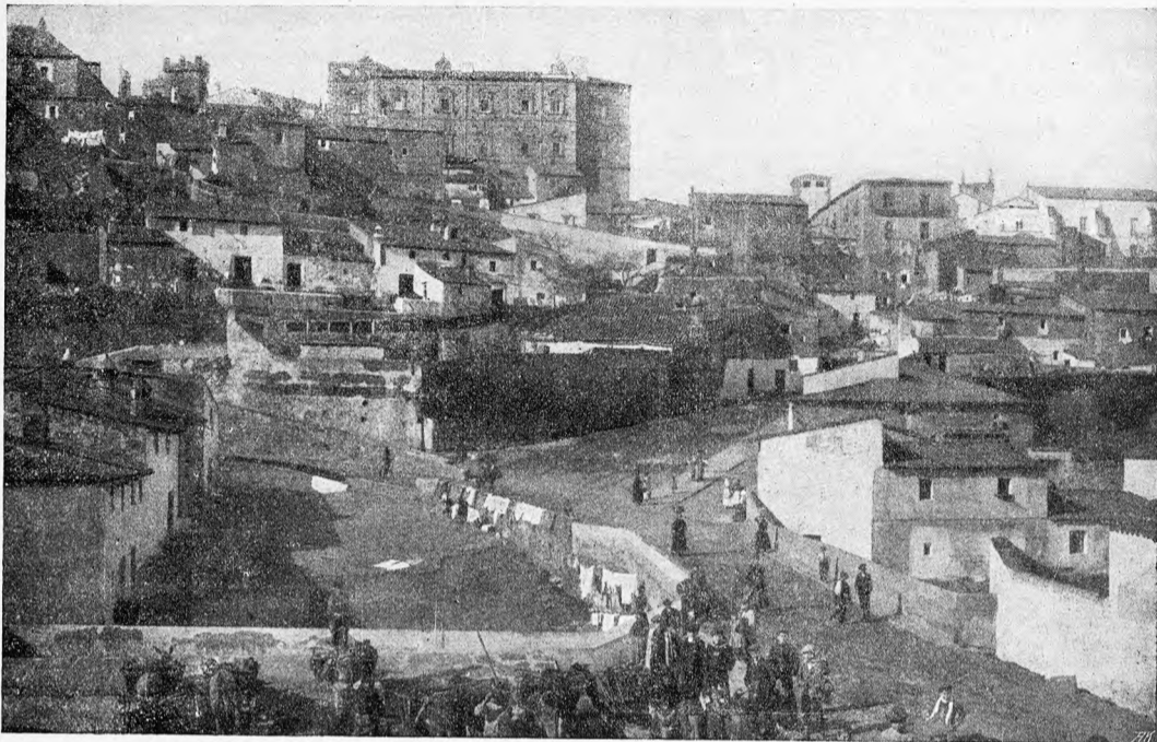
Cáceres. — Vista parcial de la ciudad
