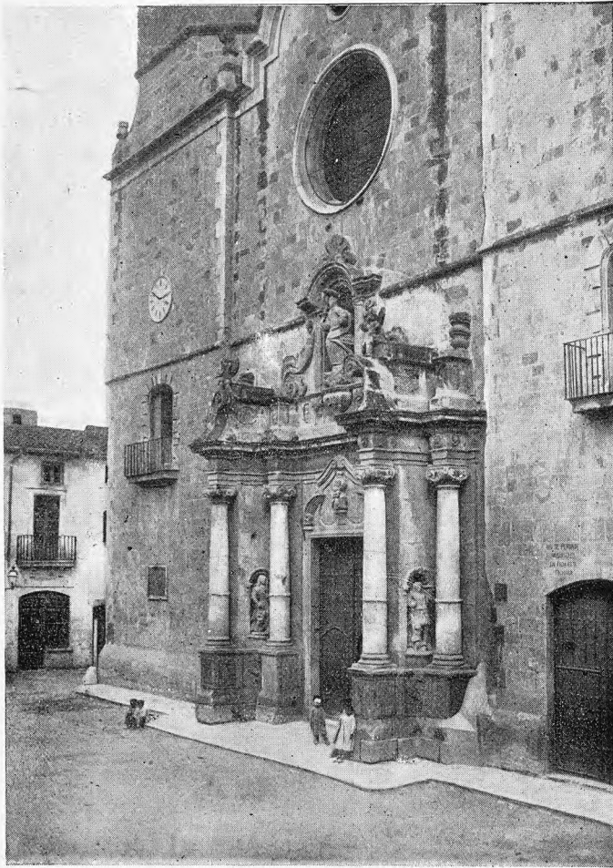
Vendrell.—Fachada de la iglesia parroquial
