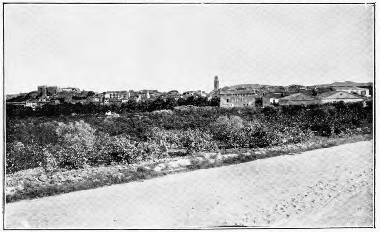
FALSET. — VISTA PARCIAL
