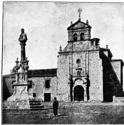
ERMITA DEL MIRÓN (FACHADA)
