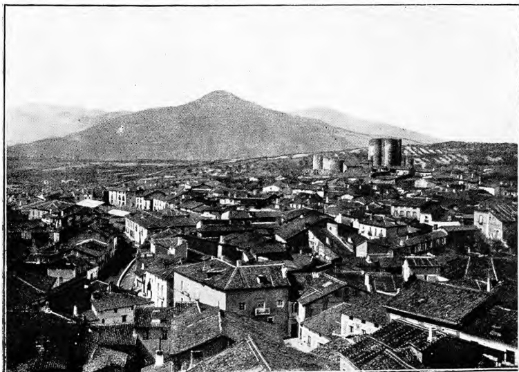
SAN MARTÍN DE VALDEIGLESIAS. — VISTA PARCIAL
