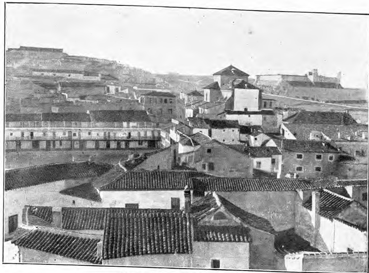
CHINCHÓN. — VISTA PARCIAL
