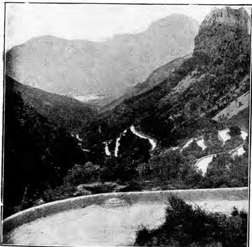
CARRETERA DE SÓLLER
