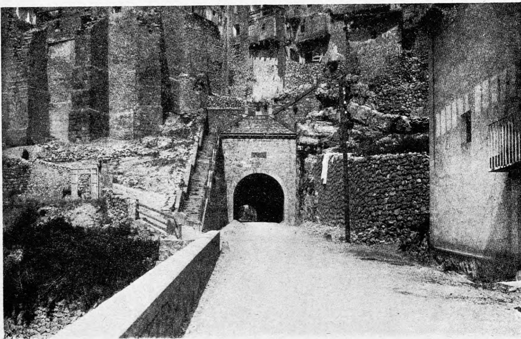
La carretera de Teruel a Checa, al pasar por el túnel de Albarracín
