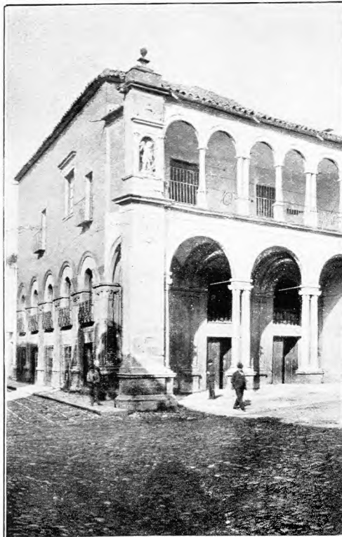
ÚBEDA. — ANTIGUA CASA CONSISTORIAL
