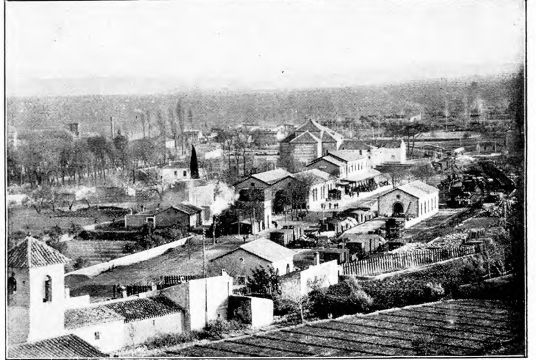
BAZA. — VISTA DE LA ESTACIÓN DEL FERROCARRIL
