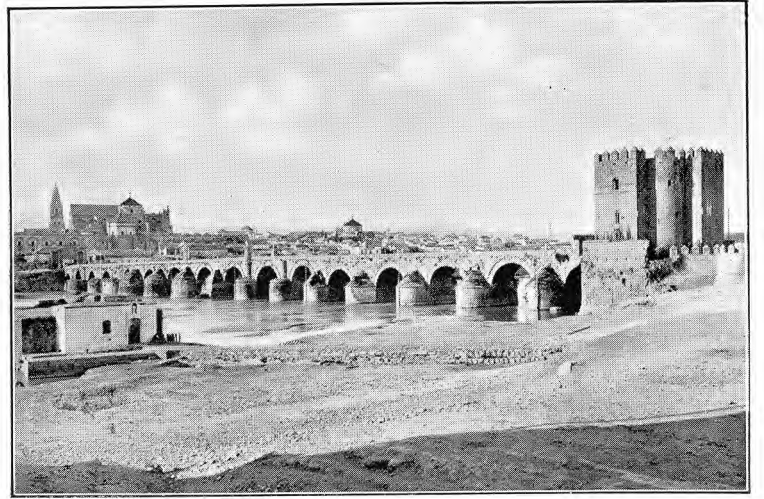
PUENTE SOBRE EL GUADALQUIVIR
