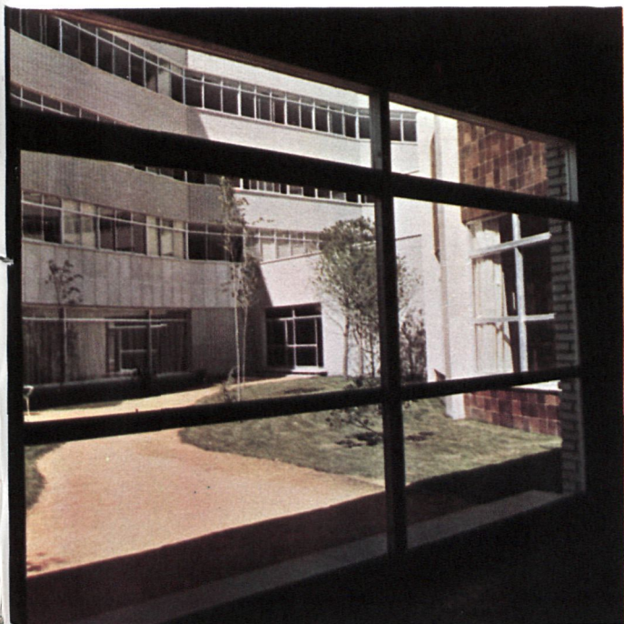
A la izquierda, vista exterior de la entrada principal y la escalera de acceso al salón de actos. En esta página, dos aspectos de uno de los espacios interiores ajardinados.
