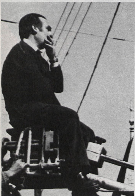
José Luis, sobre la grúa, trabaja
