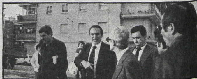
Rosón visita las obras del paso elevado de la avenida de España. Le acompañan el alcalde, Ángel Berrendero, y el diputado y concejal Sócrates Gómez
