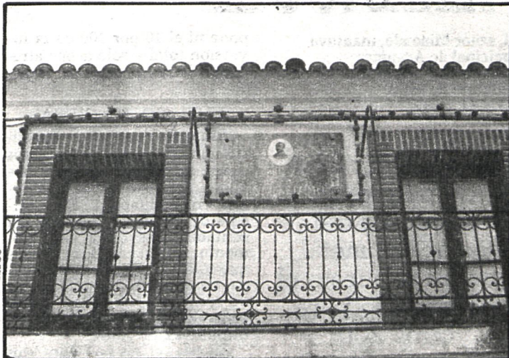
En la misma fachada del Ayuntamiento, la placa de Franco sigue dando nombre a la plaza
