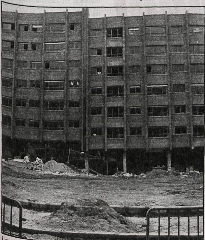
Las nuevas viviendas suelen estar acondicionadas para evitar que se cueulen ratas por los huecos de los pisos
