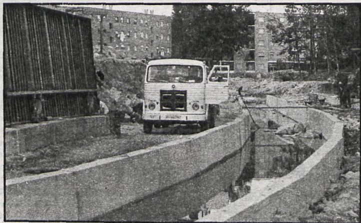
Este es el estado actual de las obras que se llevan a cabo en Collado Villalba
