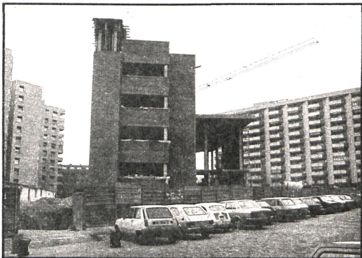
La Corporación de Parla afirma que la construcción masiva traería de la mano una peligrosa aglomeración en el municipio
