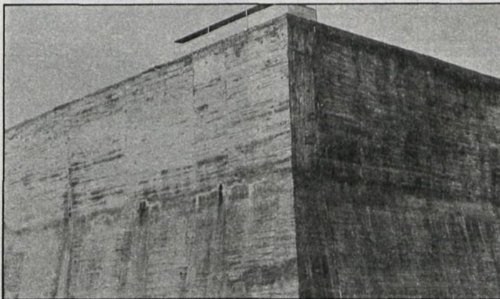
Depósito de aguas de Aranjuez: construcción defectuosa y, consecuentemente, fugas constantes
