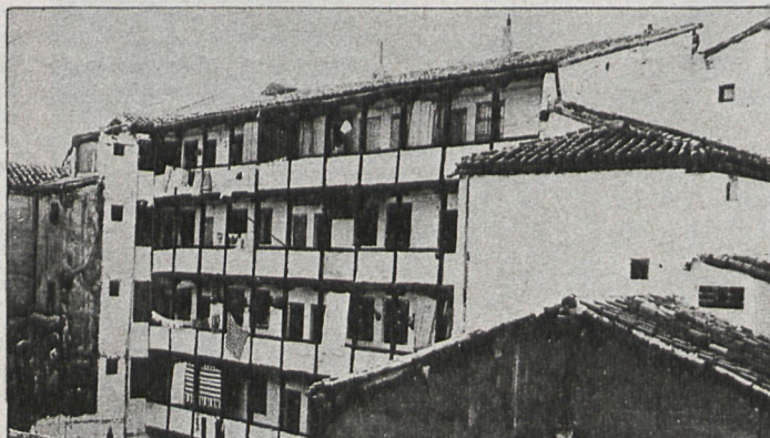
Las obras en la Corrala de Miguel Servet tropezaron con algunos problemas de falta de información, que han sido subsanados
