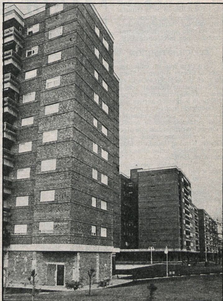
El Ayuntamiento de Alcorcón ha solicitado al Canal de Isabel II la redacción de un proyecto sobre adecuación de la acometida de aguas a la zona de San José de Valderas, que aparece en esta fotografía
