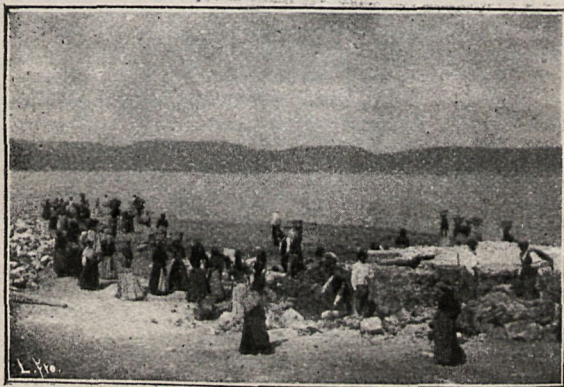
OBRAS DE FORTIFICACIÓN
