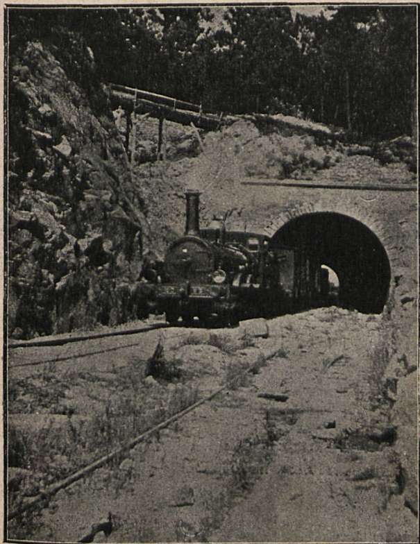
PORTUGAL: Tren saliendo de un túnel en Colinas de San Benito. (Porto).
