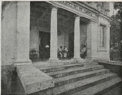
Vestíbulo de entrada.
