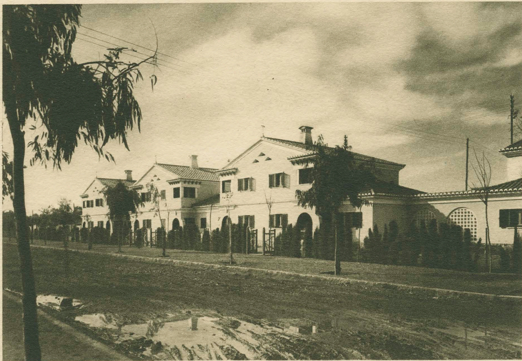
SAGUNTO (Valencia): Viviendas para empleados de Altos Hornos.
