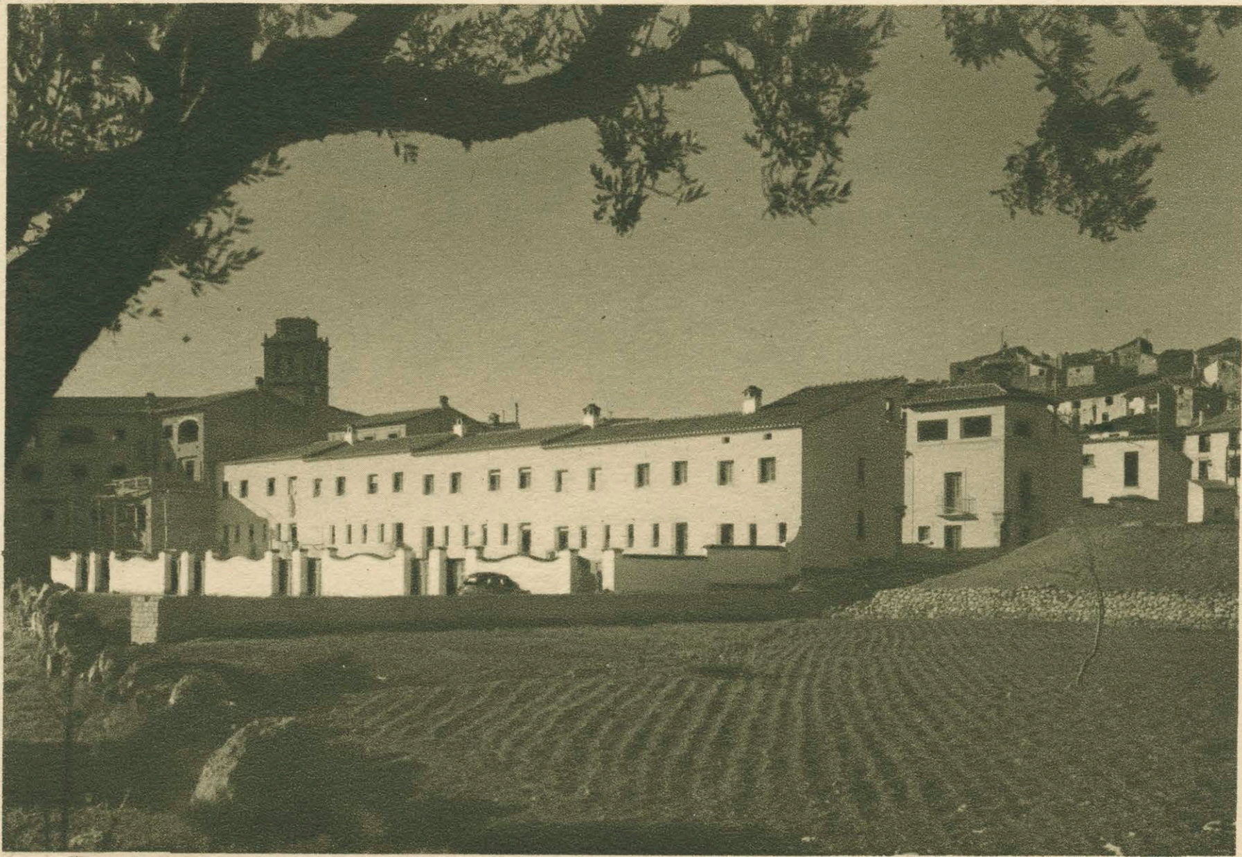
VIVER (Castellón): Bloque de viviendas para labrador.
