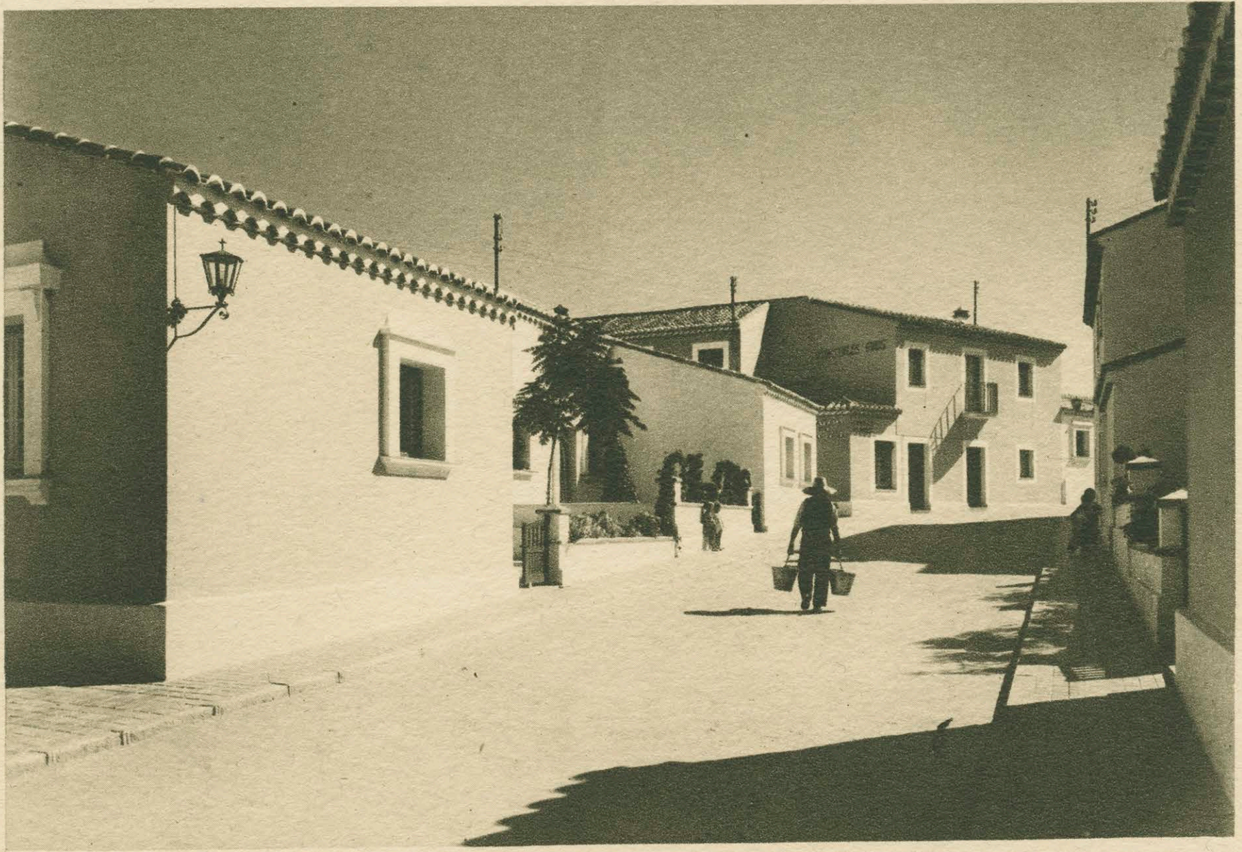
ARAVACA (Madrid): Viviendas.
