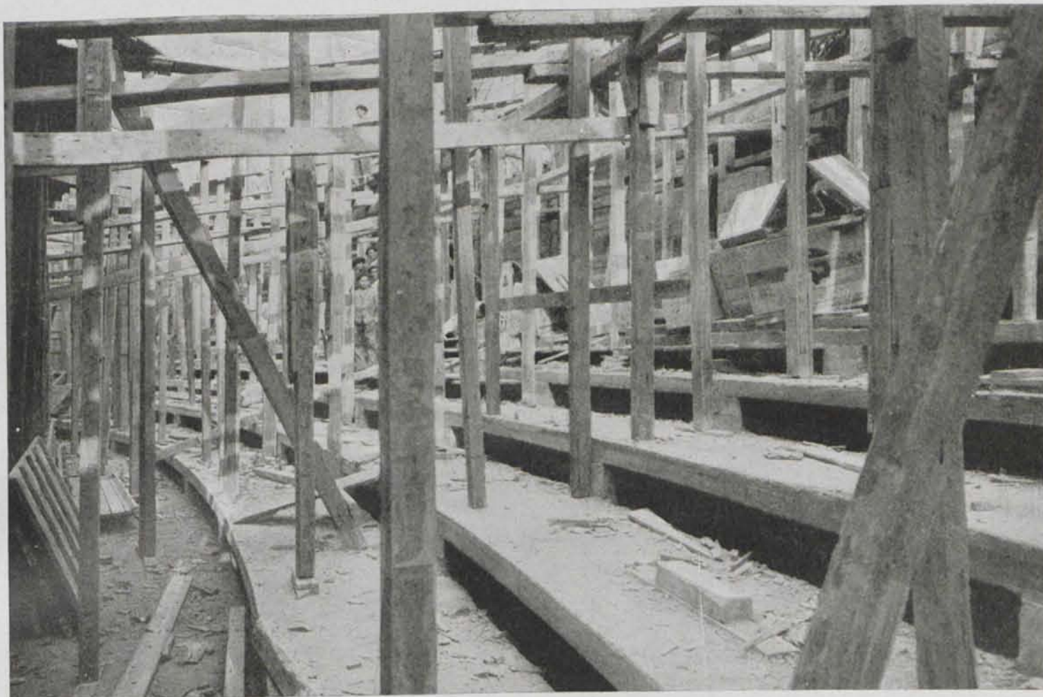
Anfiteatros. Gradas de hormigón.
