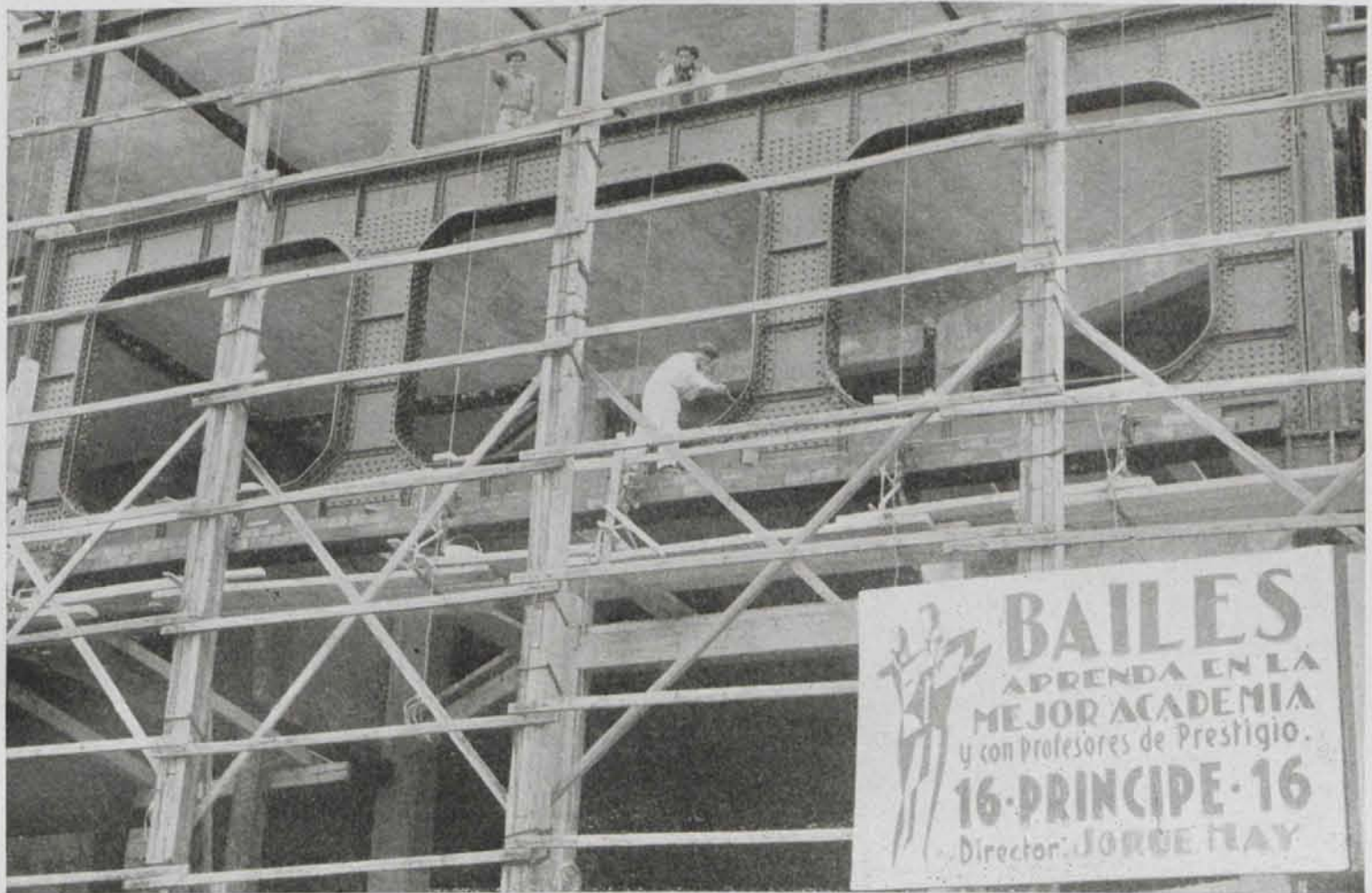
Montaje de la viga Vierendell de la entrada del Cine.
