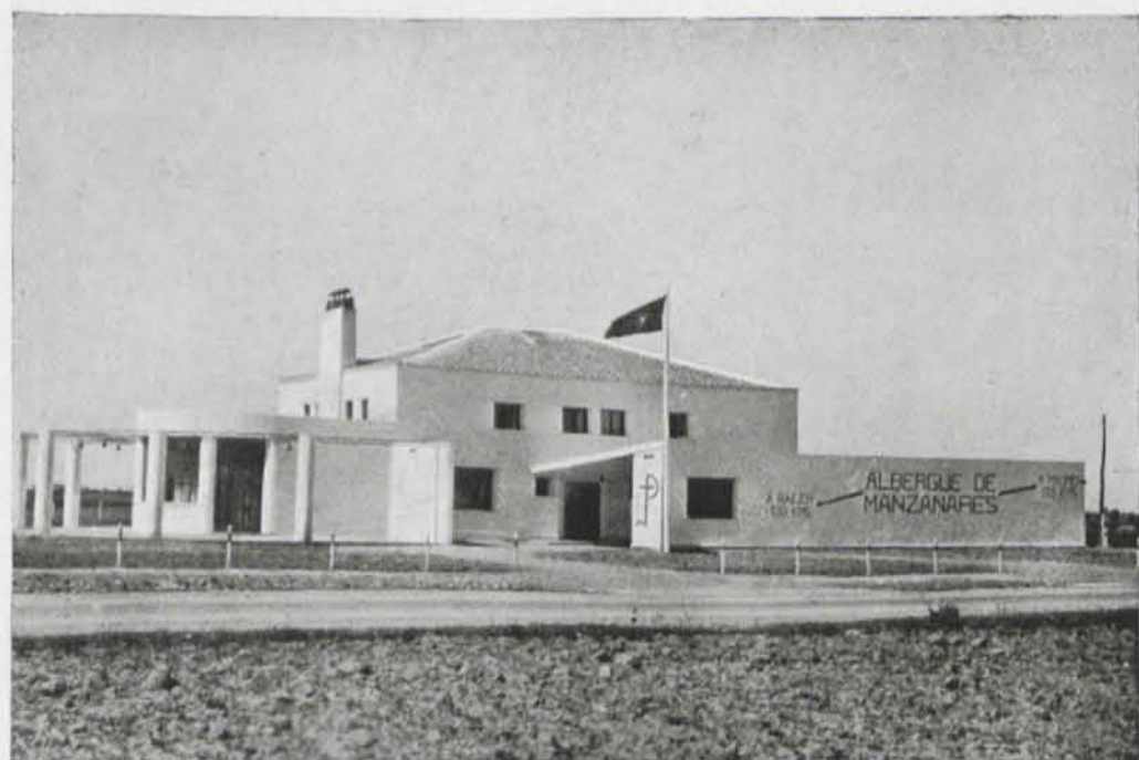
SALÓN Y VISTA EXTERIOR DEL ALBERGUE DE MANZANARES.
