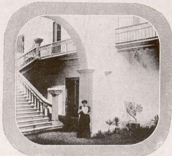
El Hall (en construcción).
