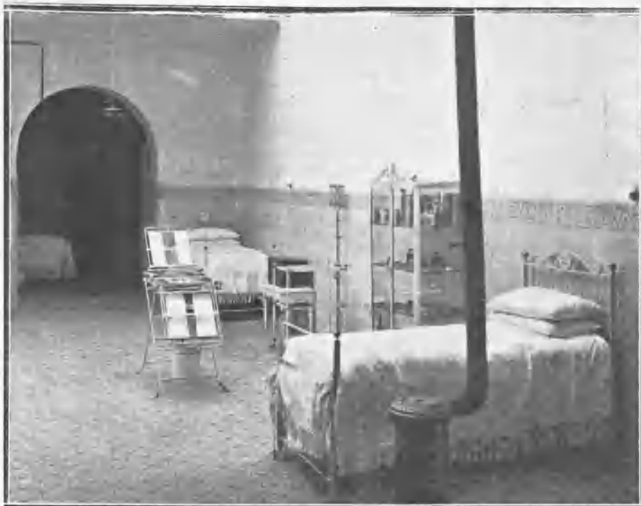
LA ENFERMERÍA DESPUÉS DE LA ÚLTIMA REFORMA
