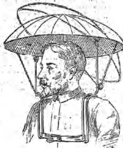
Cerca del punto de contacto de los trozos de alambre con las correas existe un cordoncillo, mediante el cual, tirando de uno ú otro lado, se consigue mover el paraguas en todas direcciones y colocarlo en la posición más conveniente.
