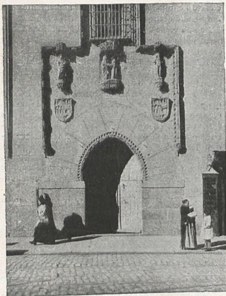
MADRID: PUERTA DEL HOSPITAL DE LA LATINA Inst. del Dr. Hernández Briz.
