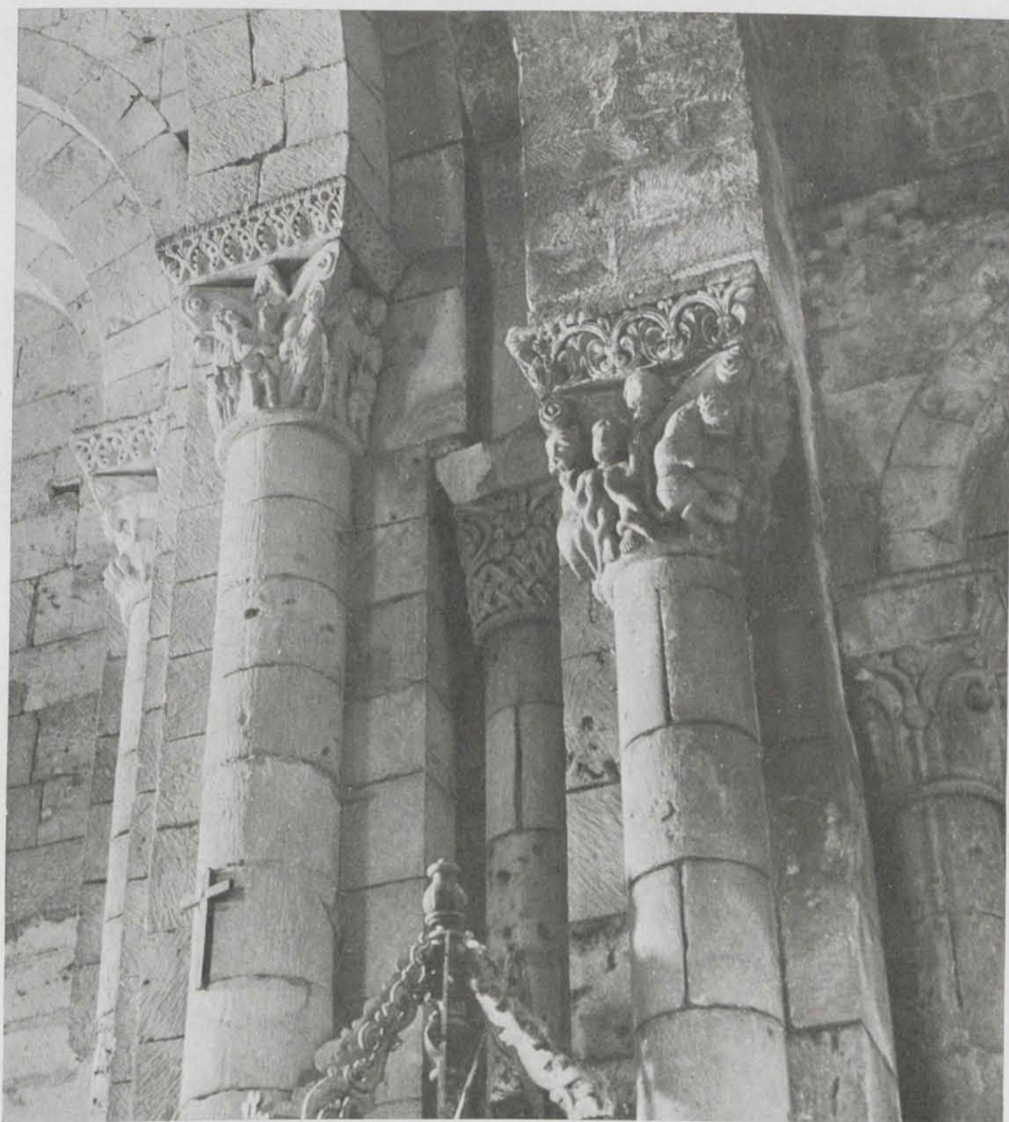
Figura 15. Detalle del empalme de las obras de los dos maestros.
