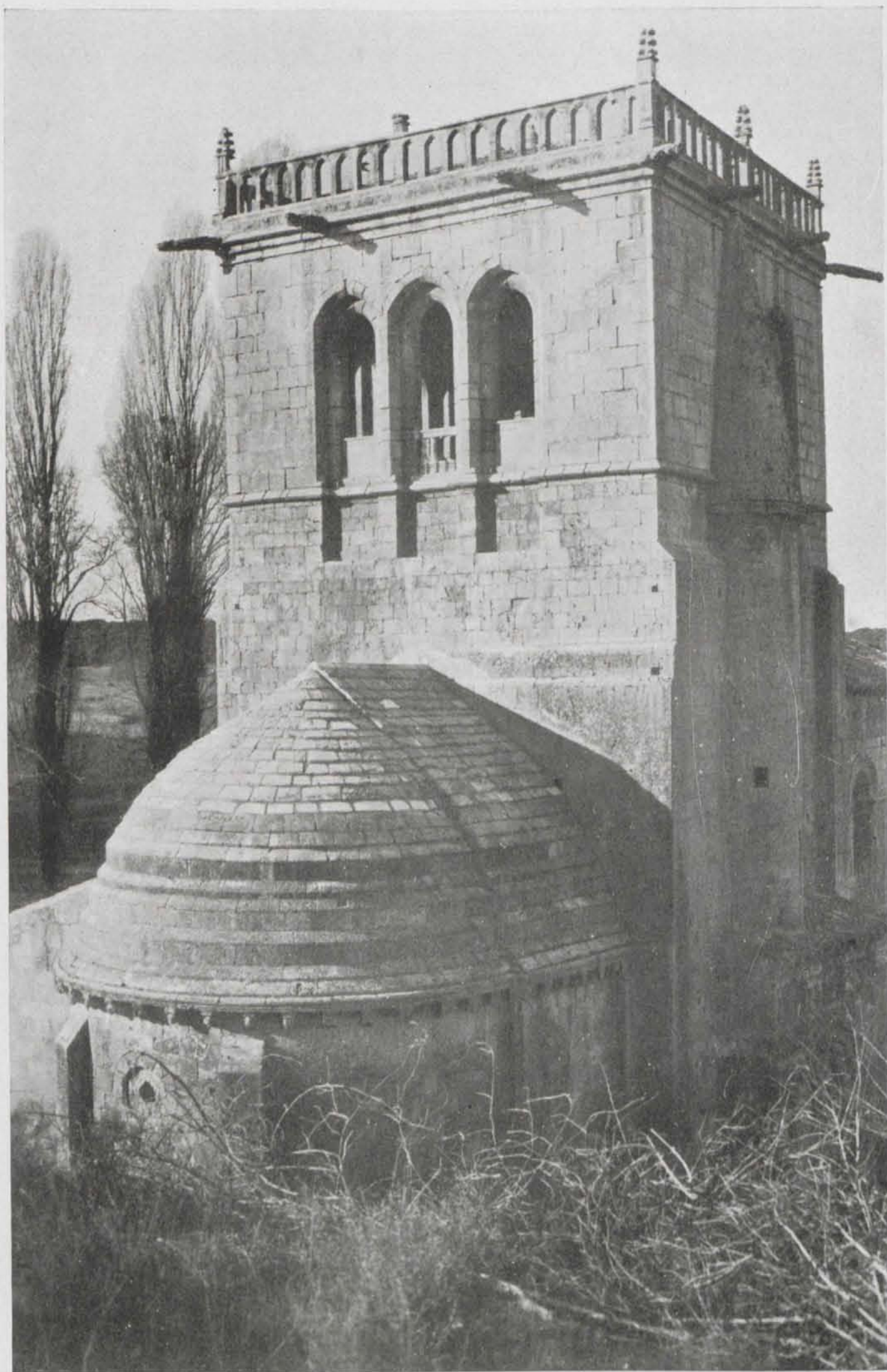
Figura 1.ª. Abadía de San Quirce. Abside y torre después de las obras.
