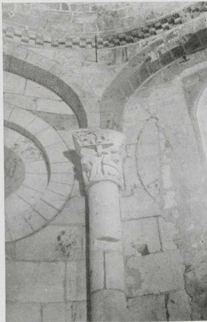
Figura 14. Detalle del ábside.
