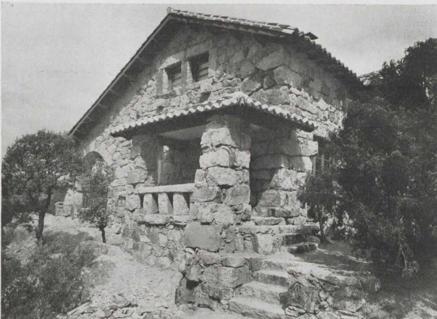
Detalle del porche de acceso.
