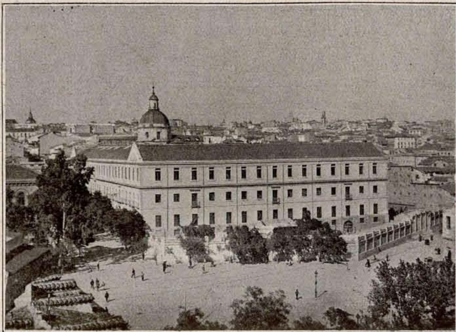
Vista del edificio después de las obras de reforma y mejora últimamente realizadas
