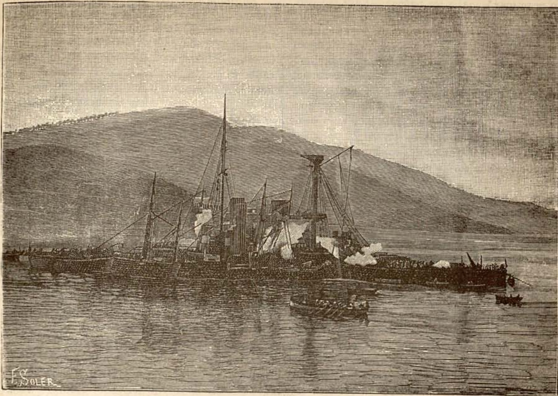
Fig. 2.—REMOLQUE DADO AL «HOWE» PARA LLEVARLO AL DIQUE.
