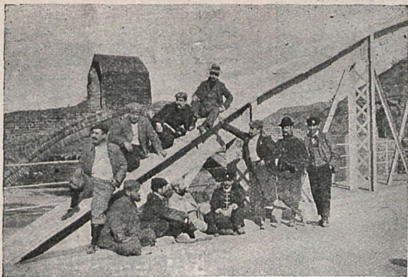
PUNTE DE HIERRO Y EL PONT DEL DIABLO CONSTRUÍDO POR AMILCARBARCA Inst. de A. Ferrer.
