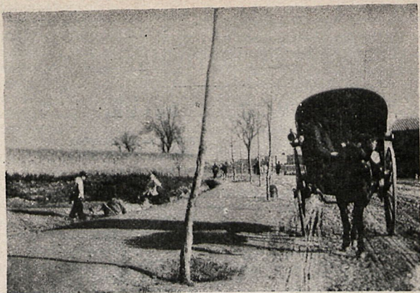
CARRETERA DE SARRIÁ—Inst. de F. Averly.
