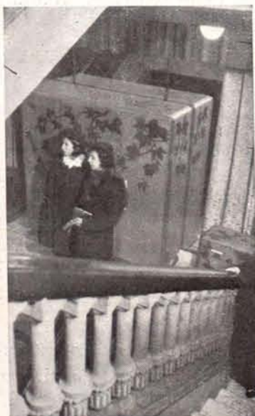
DETALLE DE UNA DE LAS MEDITAS DE ESCALERA
