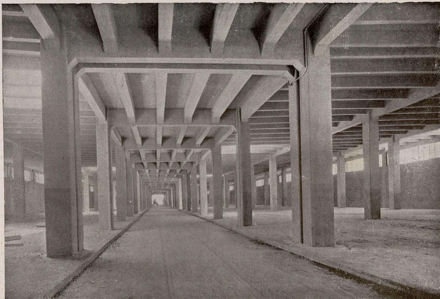
Vista parcial del mercado central de frutas y verduras, pavimentado con asfalto fundido.
