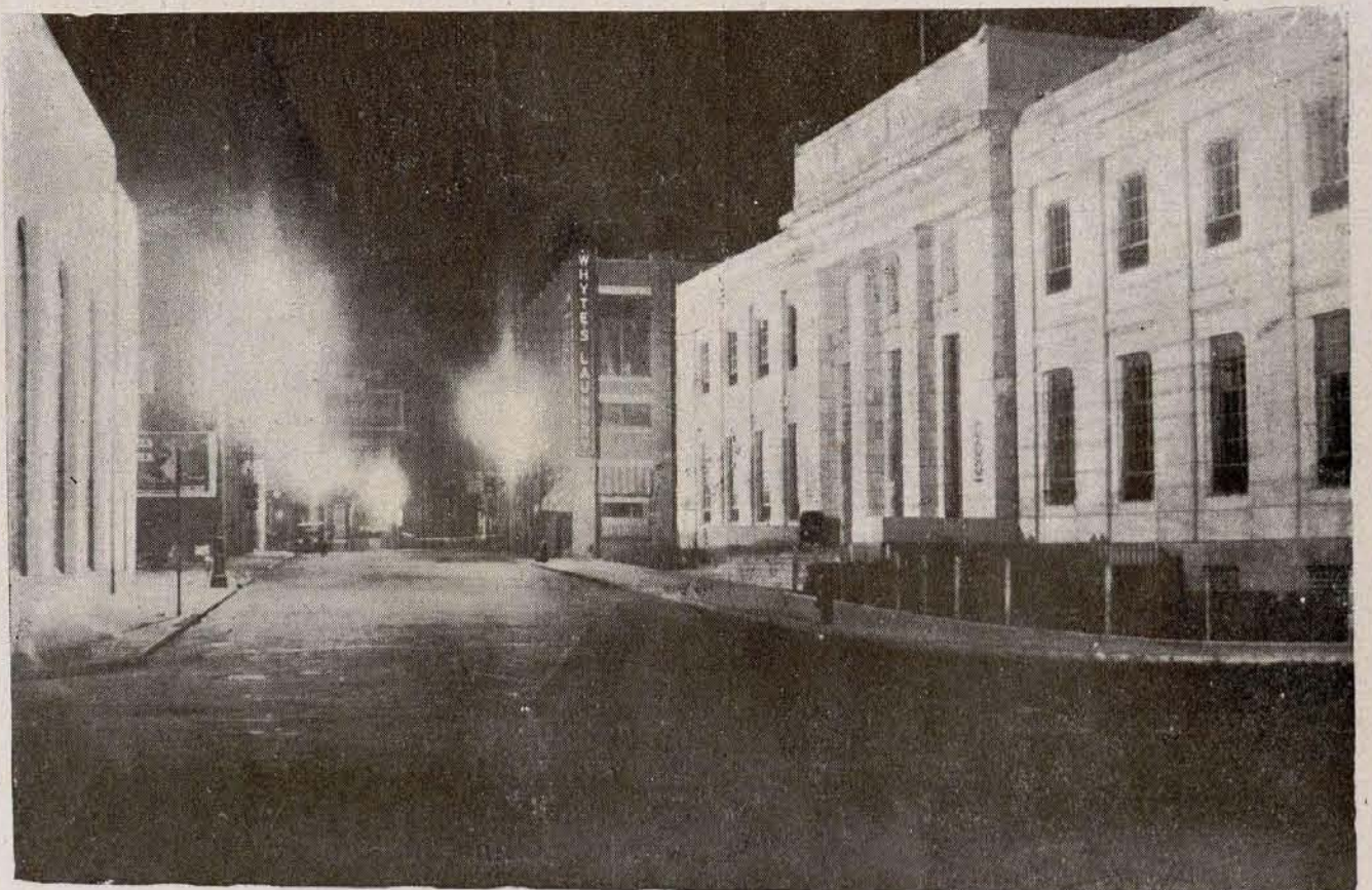
La misma calle, iluminada por la noche con lámparas de sodio.
