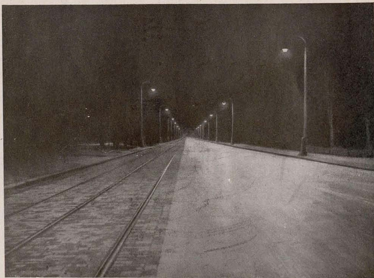
Alumbrado por lámparas de mercurio de 275 w. Distancia entre postes, 67 m.; entre lámparas, 33,5 m., y altura, 8,5 m., en la Berliner Strasse, de Berlín.
