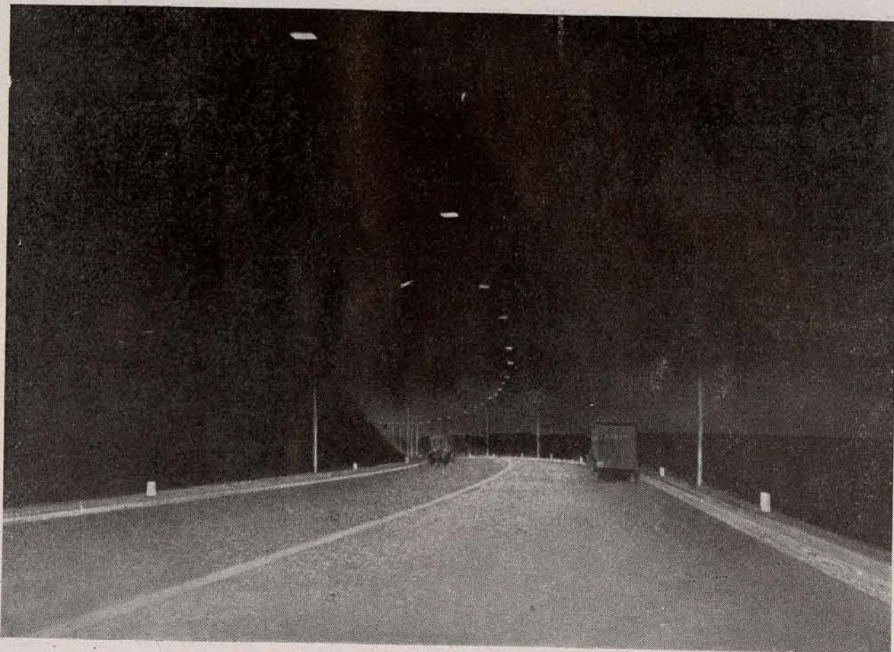
Alumbrado por lámparas de sodio en la autopista Colonia Bonn. Distancia entre postes, 65 m.; ídem entre lámparas, 25; resp., 16 m.; altura, 10 m.; resp., 8 m.
