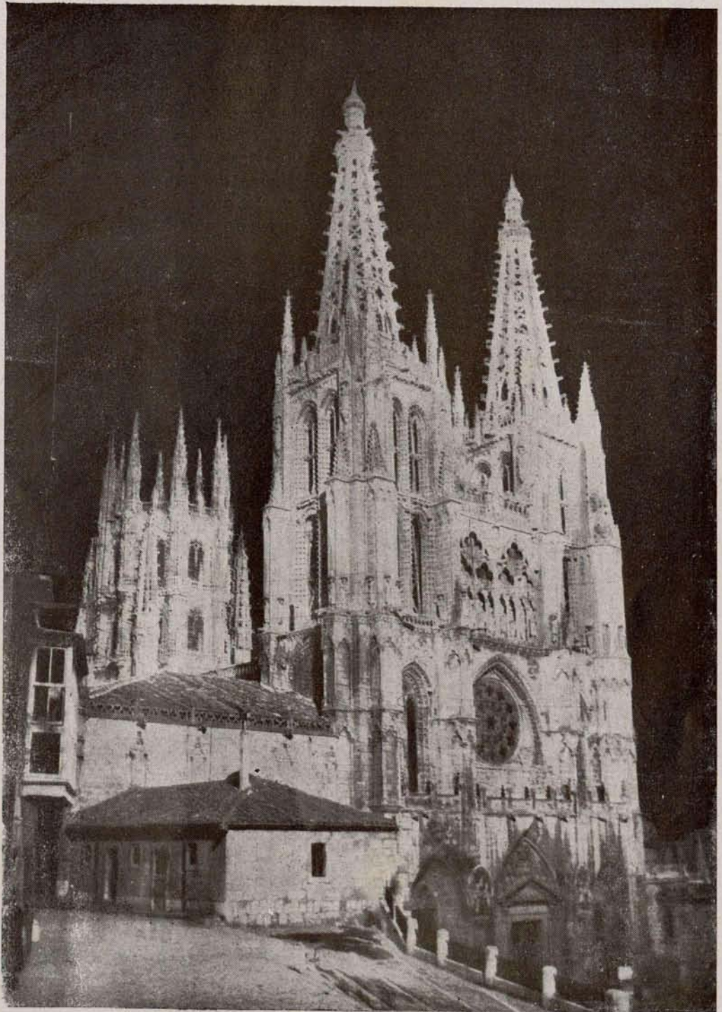
La catedral de Burgos: Iluminación con proyectores provistos de lámparas de incandescencia.
