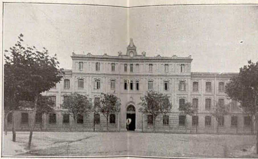
Fachada principal de la Fábrica de Tabacos.
