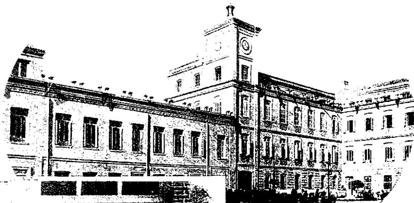
Vista del pabellón del Colegio de la Paz, que ha sido inaugurado por SS. MM. los Reyes.
