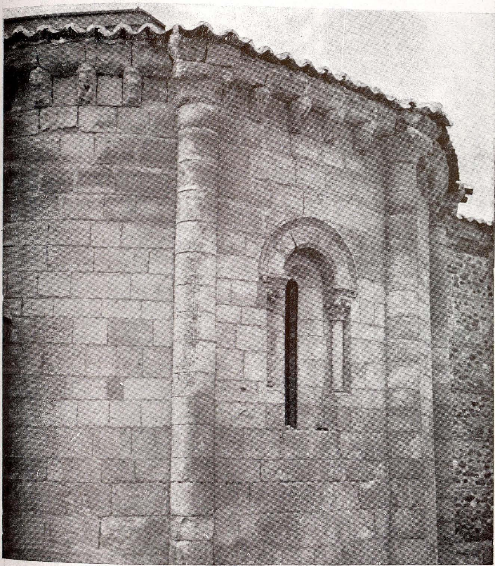
TALAMANCA.—Iglesia Parroquial (M. N.) El ábside, de puro estilo románico, muestra su típico ventanal de medio punto, canecillos y contrafuertes de columnas... (Foto Leal.)
