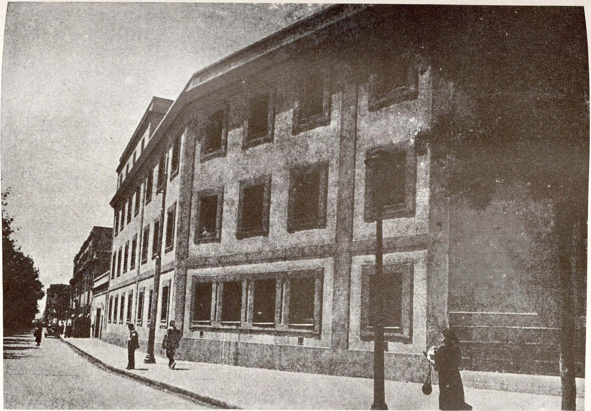
Hospital Provincial.—Nuevo Pabellón de Urgencia, recientemente inaugurado. Al fondo, a la izquierda, nuevo Pabellón de Consultas (en construcción).
