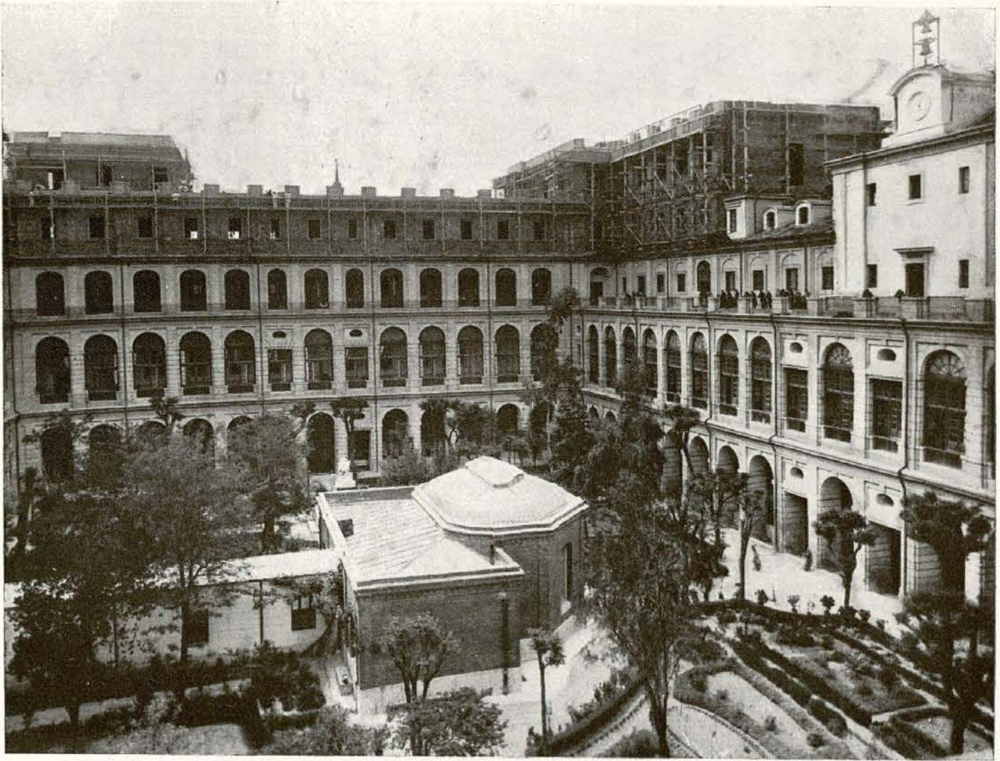
Hospital Provincial. —Patio central con las nuevas salas construidas.
