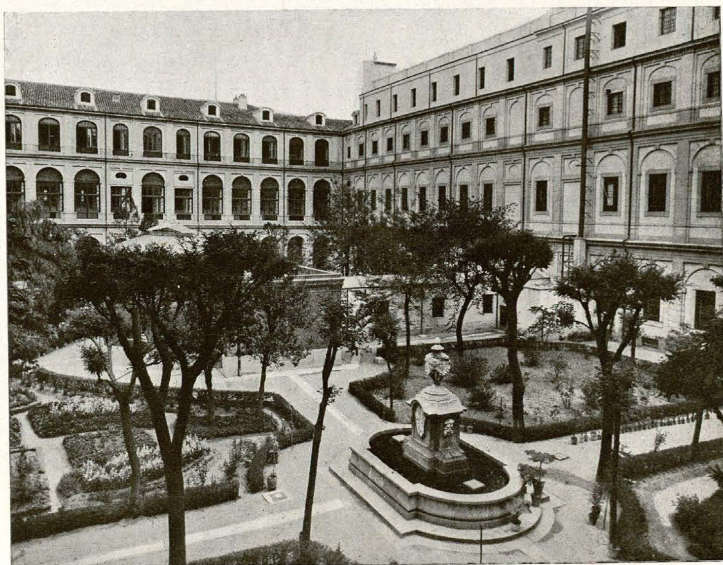
Hospital Provincial. —Patio central con las nuevas salas construídas.
