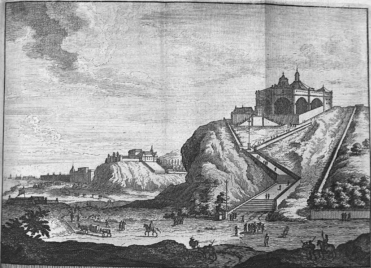
Vue du Port & de l'Eglise de BELLE-M. & de celle de S. Amat.
