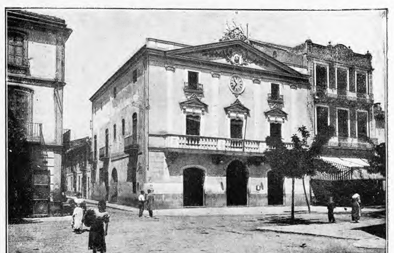
TORRENTE. — CASA CONSISTORIAL
