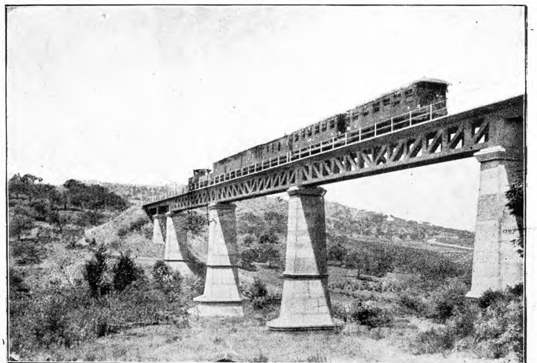
ALHAURÍN EL GRANDE. — PUENTE DEL FERROCARRIL
